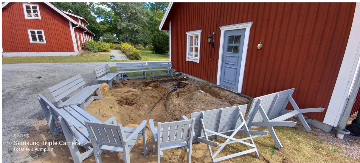
”Staketet” kring det grävda hålet. Foto: Jan Pumplun
